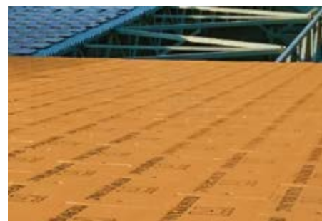
Устройство ферм кровли с ПЕНОПЛЭКС® и PLASTFOIL®
