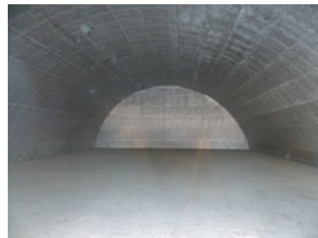
Рис. 3. Арочный ангар, утеплённый материалом Теплофол®
