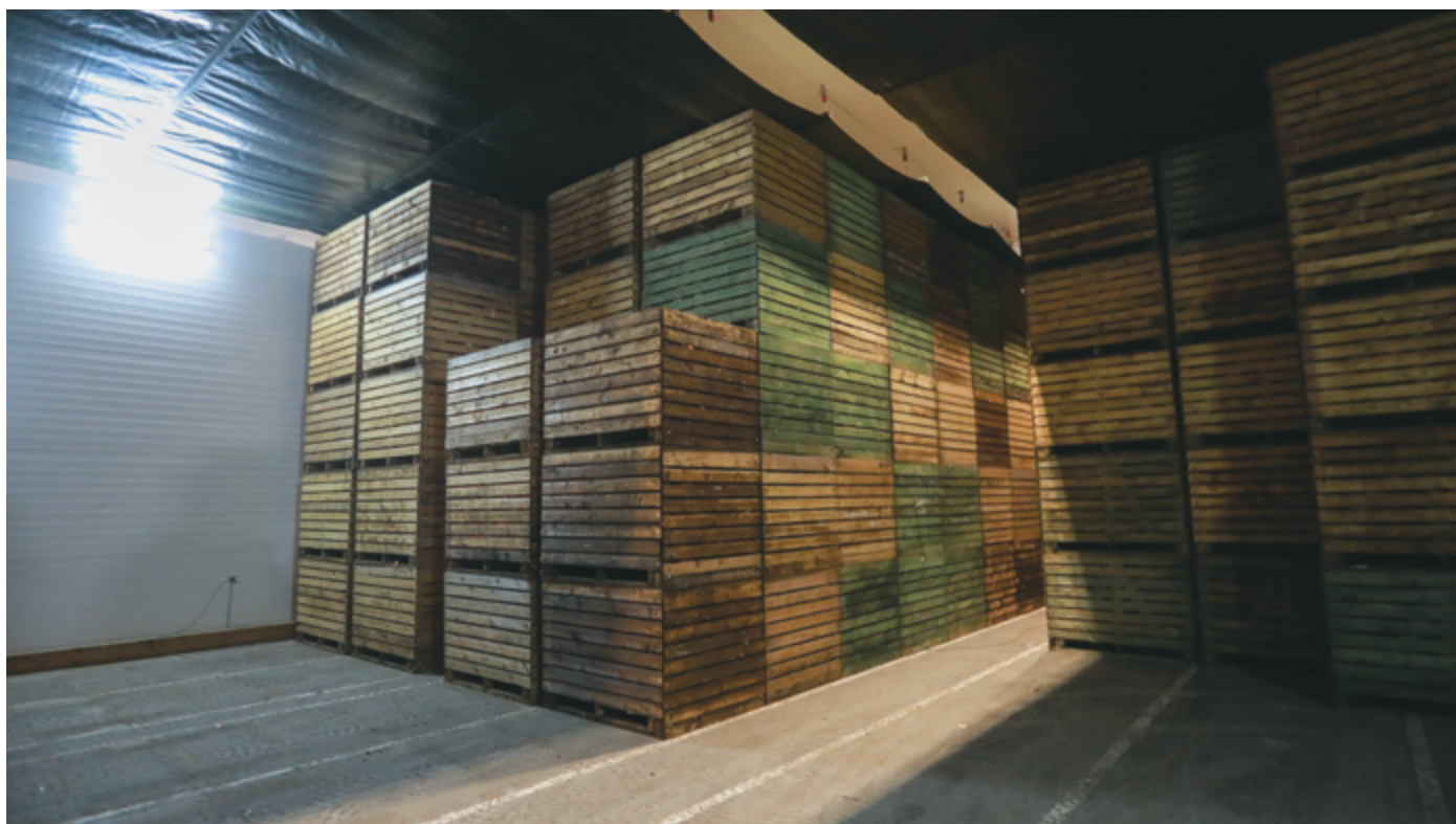
ЗАО «Племенной завод «Приневское» строительство первой и второй очередей овощехранилища суммарным объемом хранения около 15 тыс. тонн
