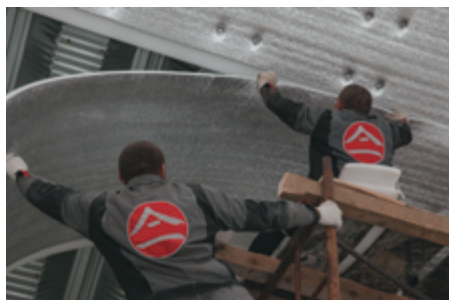
Рис. 1. Монтаж теплоизоляции и формирование замкового соединения
